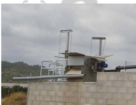
Roto-filtro RFT2000 totalmente de acero inoxidable fabricado por Mecàniques Segalés accionado por un motor de 1,5 kW con un tamiz de malla triangular con un paso de 0,25 mm.
